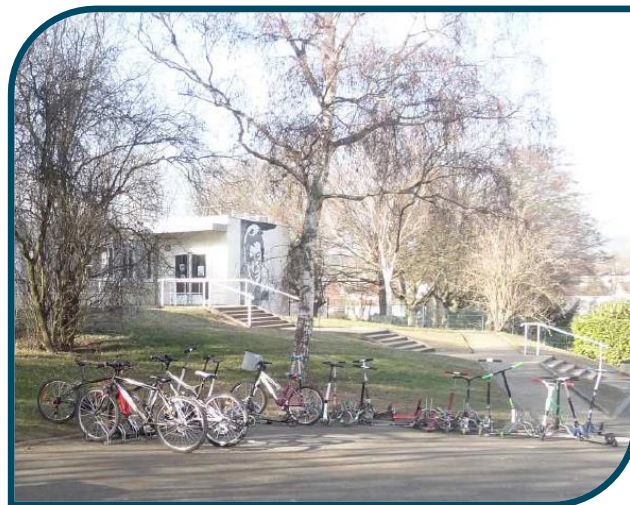
Collège Gérard Philippe, avant travaux - Crédits photo Conseil Départemental de l'Essonne
