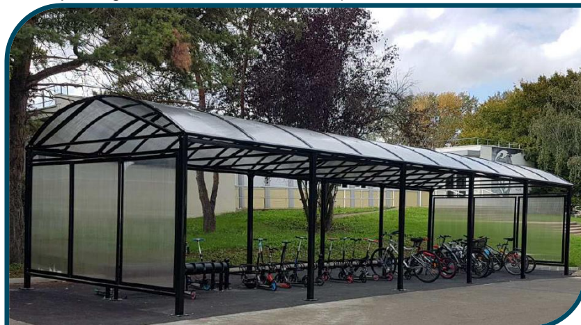
Collège Gérard Philippe, après travaux - Crédits photo Conseil Départemental de l'Essonne
